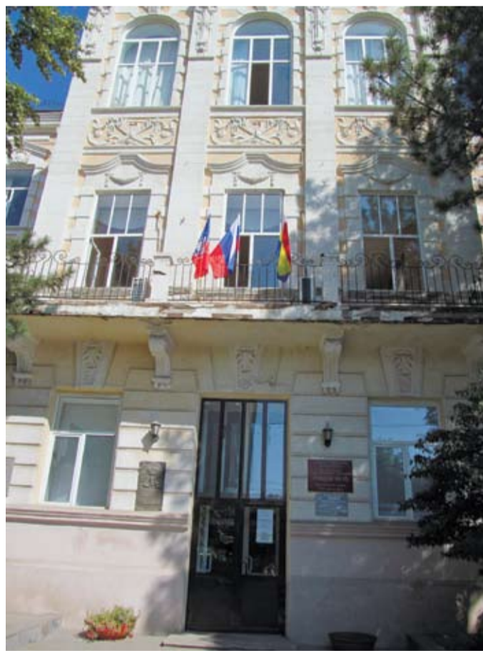
Лицей № 13 готовится к ремонту
